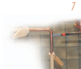
7 Θέρμανση και συγκόλληση
