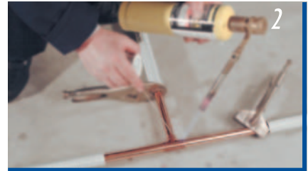
2 Συγκράτηση μόνωσης και συγκόλληση
