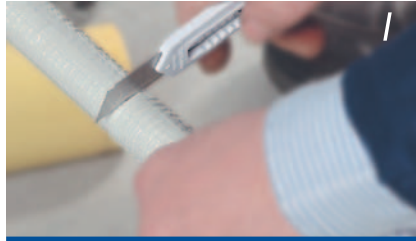
1 Περιμετρικό κόψιμο μόνωσης
